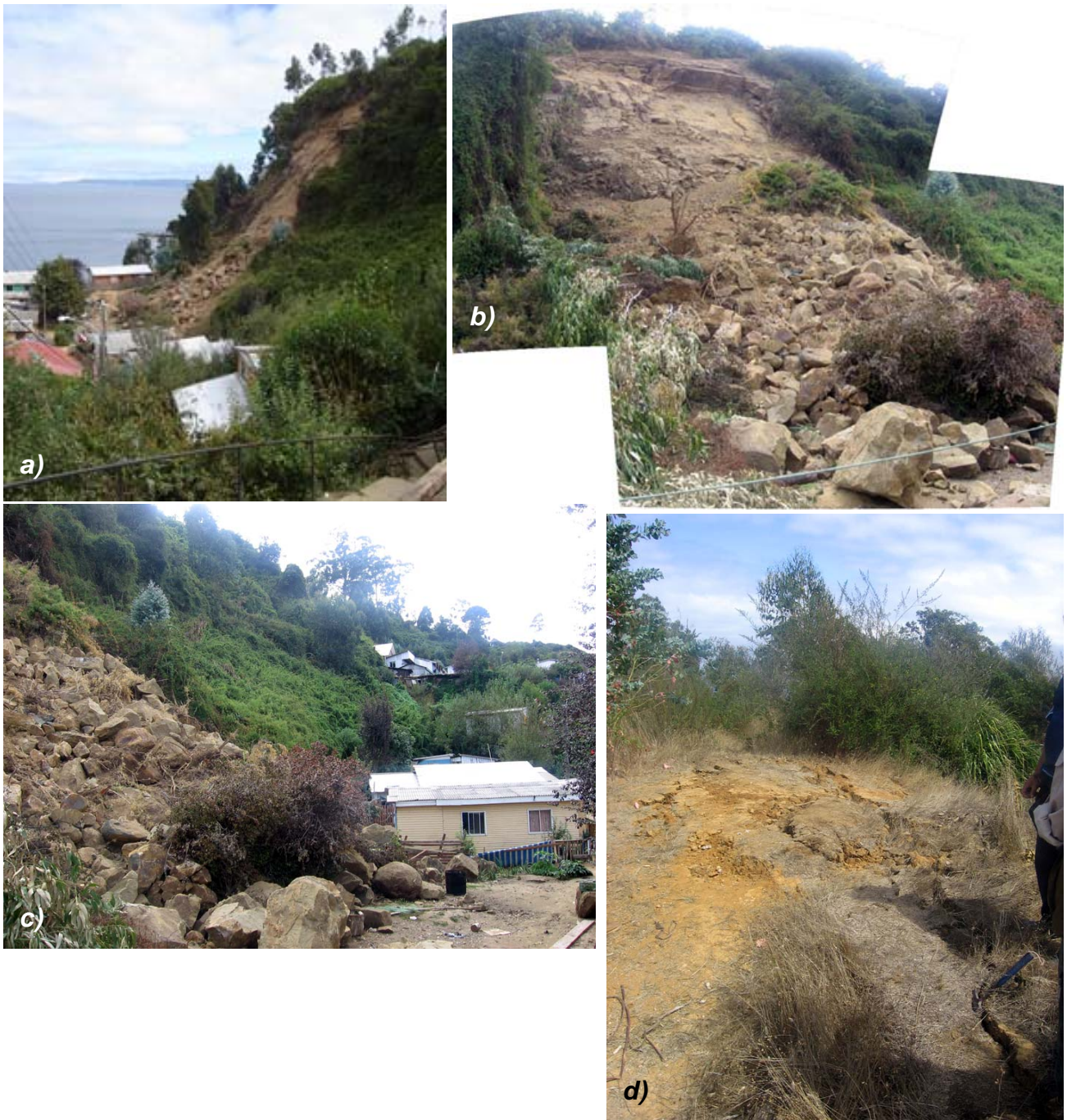
Figura 3: Fotografías del proceso de remoción en masa que afectó al sector de caleta Los Bagres. En la fotografía b) se aprecia que, en lo alto del deslizamiento, los planos de debilidad (fracturas naturales) existentes en la roca son paralelos a la ladera del cerro, lo que favoreció el desprendimiento de grandes bloques. La fotografía d) , tomada en la cumbre del cerro que sufrió el deslizamiento, muestra un agrietamiento importante en una dirección paralela al plano sobre el cual este se generó.
