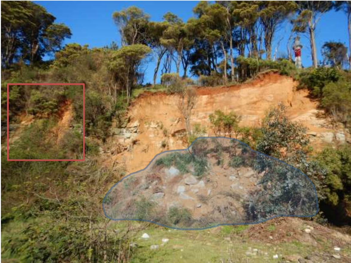
Fig. 6. Vista frontal de deslizamiento en la península de Lutrín. En la cicatriz del deslizamiento es posible ver 3 niveles estratigráficos: base de 15 m de roca poco alterada, correspondiente a areniscas verdes del miembro Lota de la Fm. Curanilahue; centro de 5 m de la misma roca, pero fuertemente meteorizada; y cobertura de 2 m de suelo residual, con desarrollo de cobertura vegetal. En la parte superior derecha se alcanza a divisar el faro de Lutrín. Se encierra con un polígono azul el depósito de la remoción y en rectángulo rojo una zona cercana que experimentó un desprendimiento menor a solo 10 m del deslizamiento.
