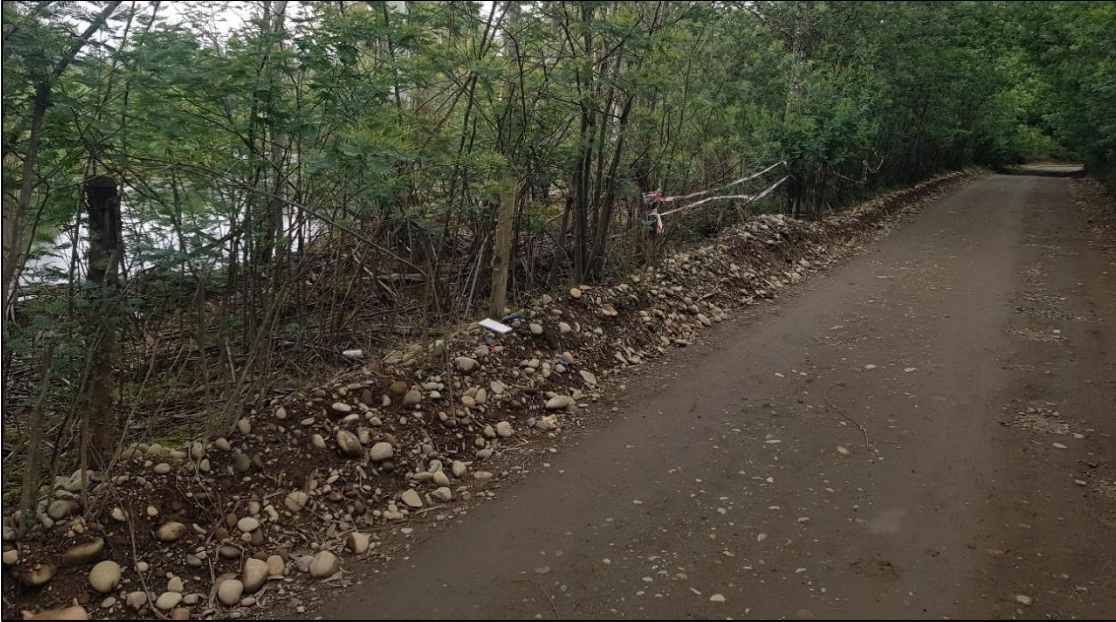
Figura 7. Fotografía del camino en el sector en que el se encuentra más cercano al borde del escarpe. Por seguridad, en el sector se instaló un cerco de alambre y cinta de peligro. El camino se encuentra en buenas condiciones y sin evidencias de asentamientos, grietas u otras deformaciones.
