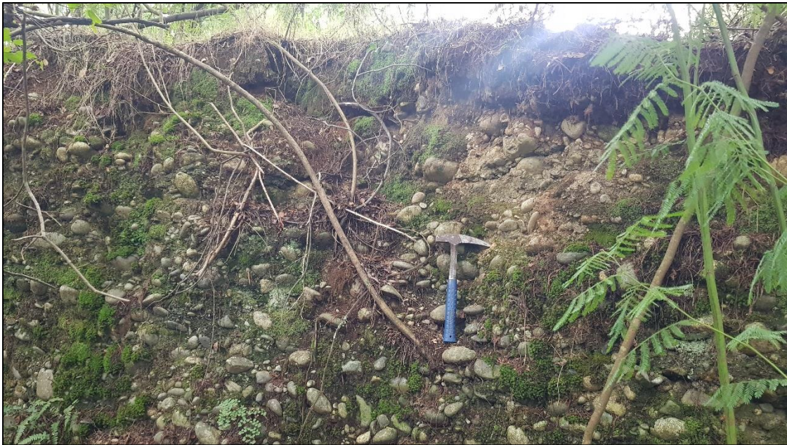
Figura 6. Fotografía del depósito de gravas y arenas gruesas no consolidadas que constituyen la ladera. Se pudo acceder solo a la parte superior del talud.
