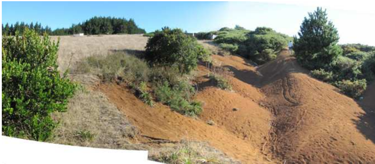
Figura 5: Vista hacia el SW del terreno de la antena. Se observa el desarrollo de una zona deprimida, correspondiente a suelo intensamente erosionado, que podría representar la traza de una antigua grieta en la cabecera de la ladera noroccidental. Además, esta estructura canaliza, probablemente, las aguas lluvias conduciéndolas hacia una quebrada que baja hacia el noreste.
