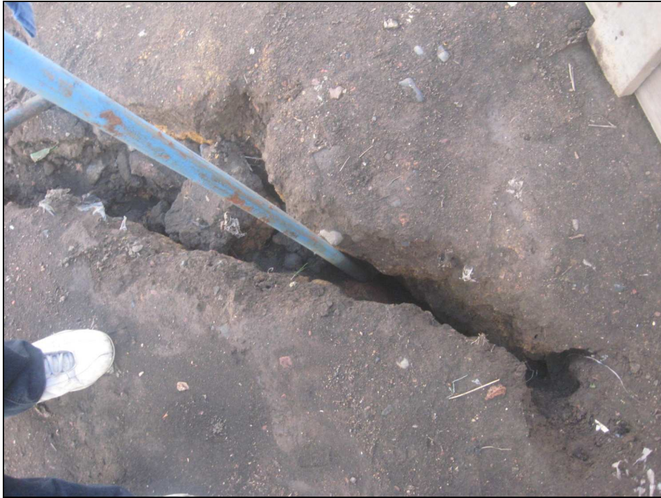
Figura 5: Profundas grietas en terreno de todo el sector recorrido.
