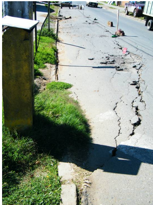
Fig. 8. Corona del deslizamiento rotacional en la calle Séptimo de Línea con Videla
