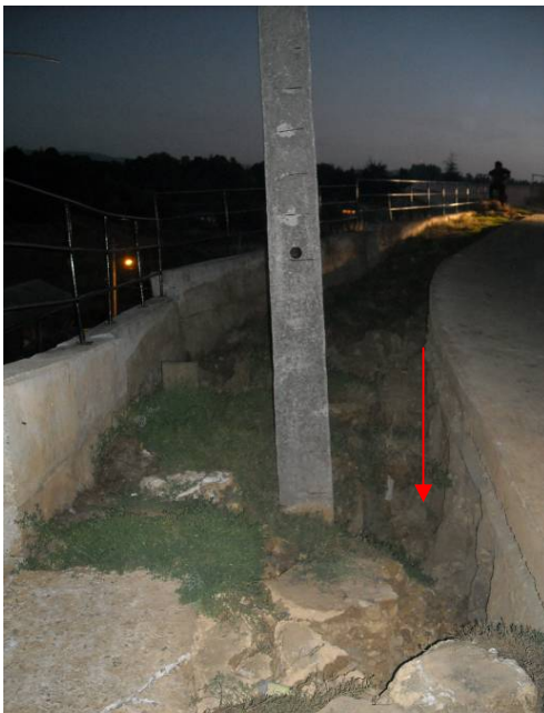
Figs. 3 y 4. Grietas con desplazamiento horizontal y vertical en la terraza edificada, entre las Calles Colo Colo y Pasaje 3 El Mirador de la Población Gajardo Sur.
