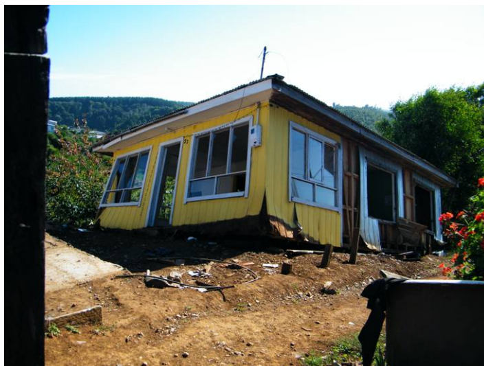
Fig. 10 Pasaje Jorge Alessandri con remoción compuesta rotacional y traslacional ubicada en el borde del escarpe de la meseta, lo cual provocó la destrucción de viviendas.
