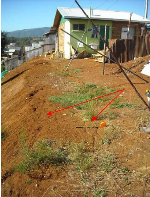
Figs. 3 y 4. Grietas con desplazamiento horizontal y vertical en la terraza edificada, entre las Calles Colo Colo y Pasaje 3 El Mirador de la Población Gajardo Sur.
