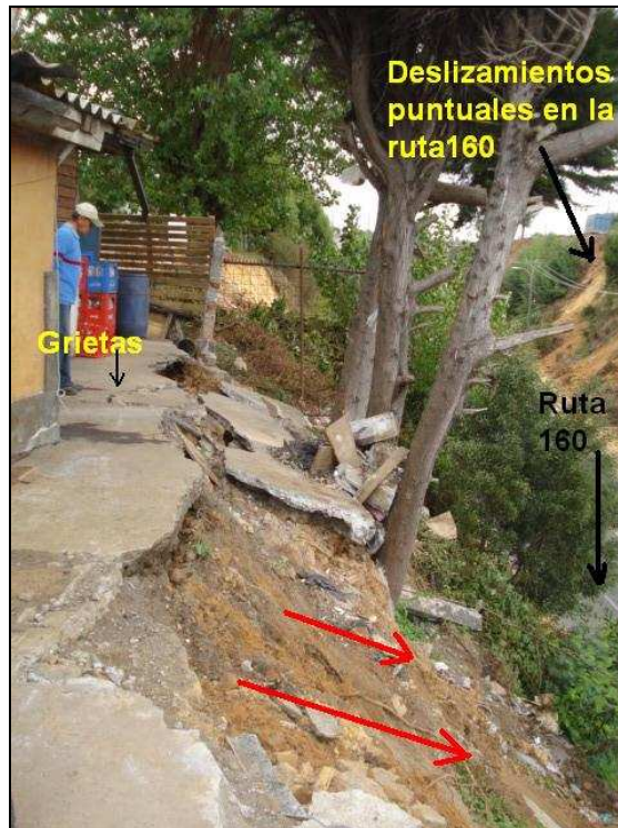
Figura 4. Deslizamiento de suelo en cercanías de la ruta 160.
