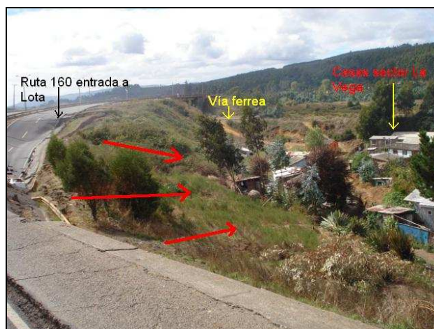
Figura 7. Ruta 160 con hundimientos cerca de La Vega.
