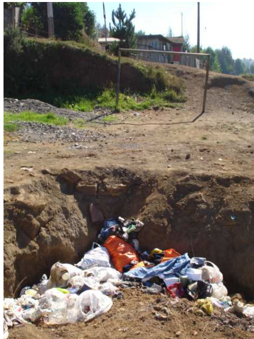
Figura 13. Grietas y excavación asociadas a pirquenes.
