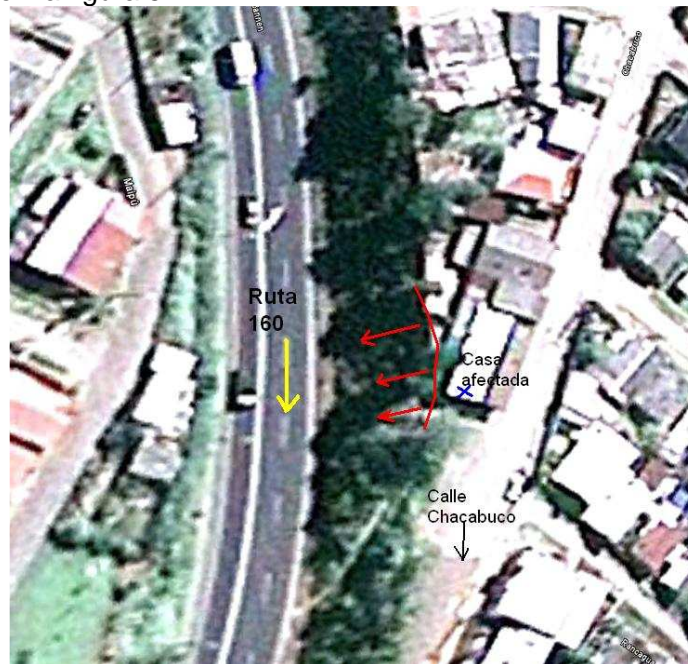
Figura 5. Deslizamiento en Ruta 160, que afecta casas en la parte superior.
