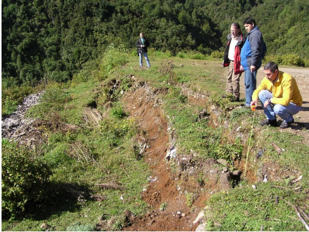
Foto 3. Grietas escalonadas y deslizamiento de suelo en sector de la Aguada.
