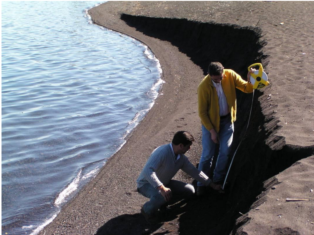
Foto 8. Escarpe y deslizamiento de terreno costero en camping Calafquén.
