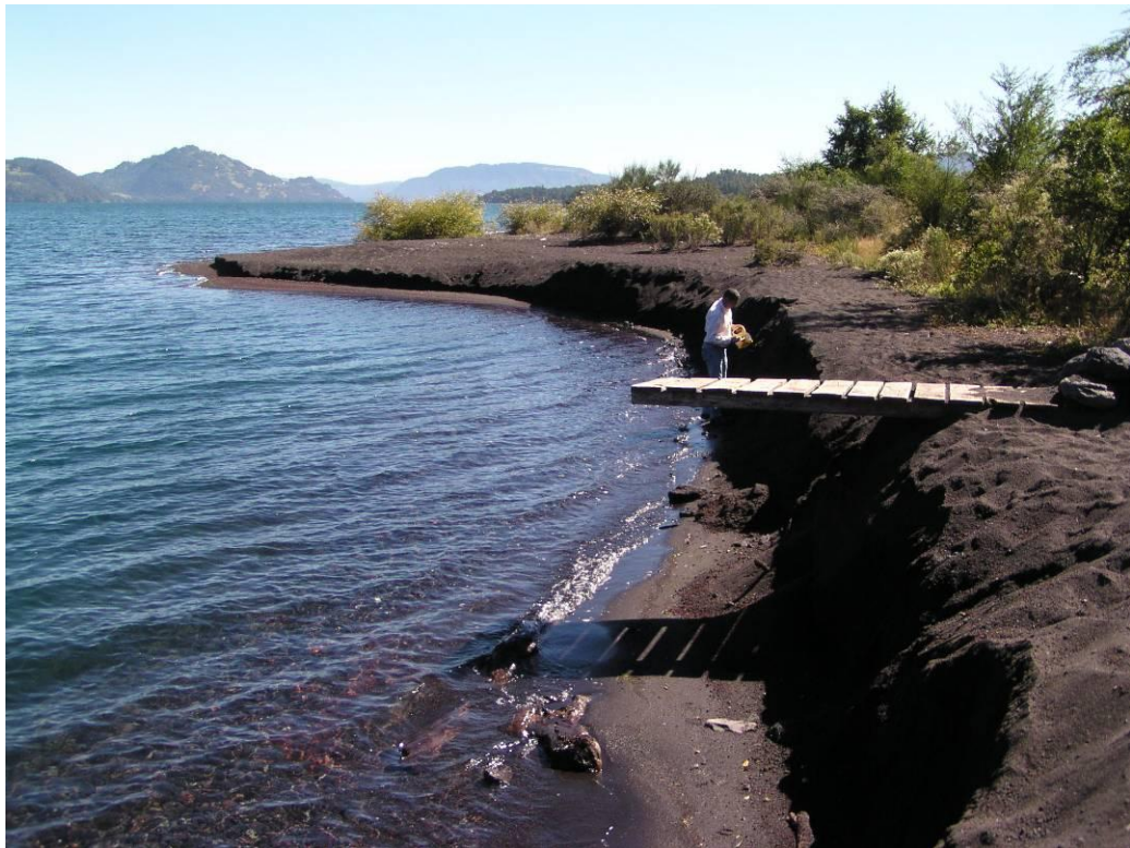
Foto 14. Escarpe de deslizamiento en sector costero aledaño al desagüe del estero Seco.
