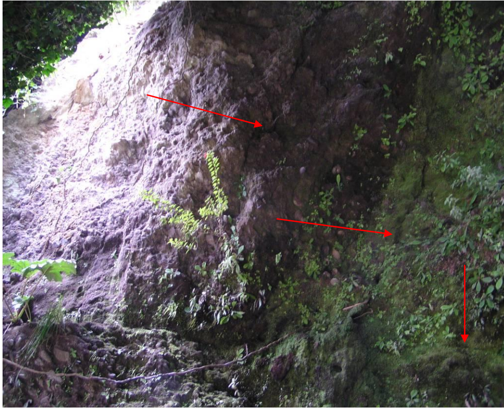
Foto1. Grietas indicadas con flechas en rojo, en el techo de la gruta a los pies del hospital de Corral.
