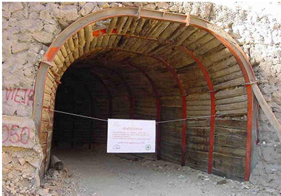
Sellado de Mina Subterránea "El Indio".
