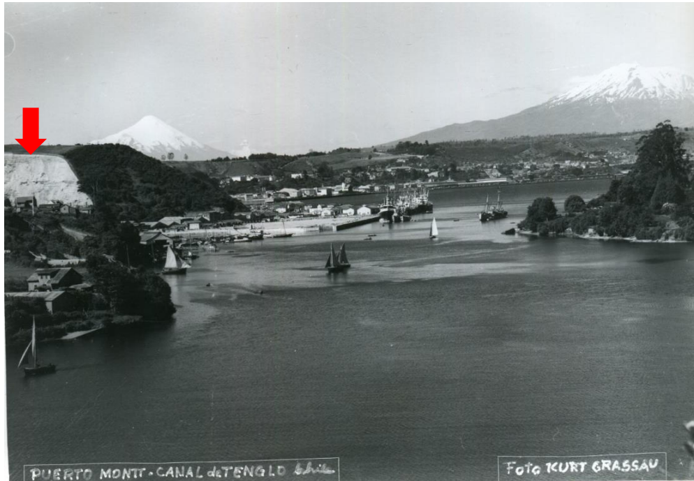
Figura 5. Fotografía del área del sector portuario (Kurt Grassau, 1958. Gentileza de E. Olsen viuda de Grassau, facilitada a SERNAGEOMIN con fines educativos y científicos). Se distingue, a la izquierda de la fotografía, remoción en masa ocurrida en el invierno de 1957 en Ladera Angelmó, indicada por flecha roja.
