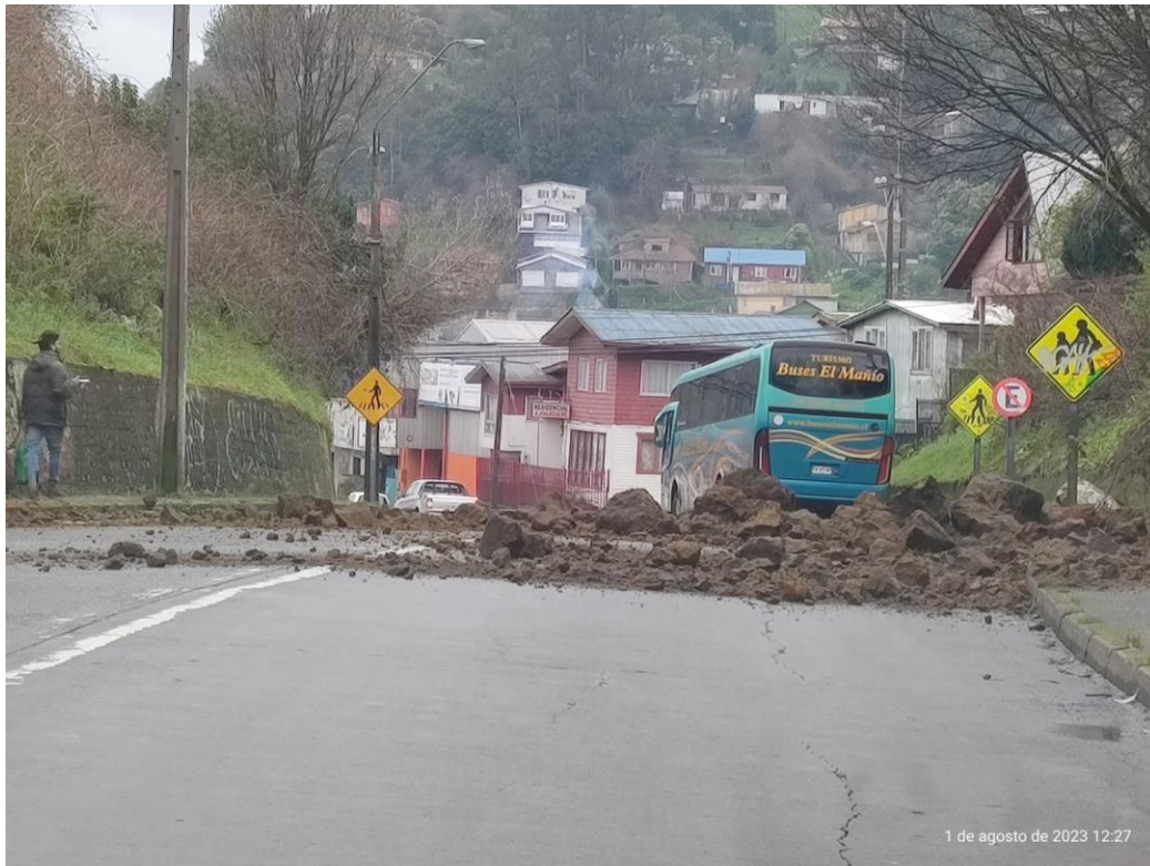
Figura 11. Fotografía de depósito que impactó Calle Ecuador el 01 de agosto de 2023 constituido, principalmente, por bloques de arenas.
