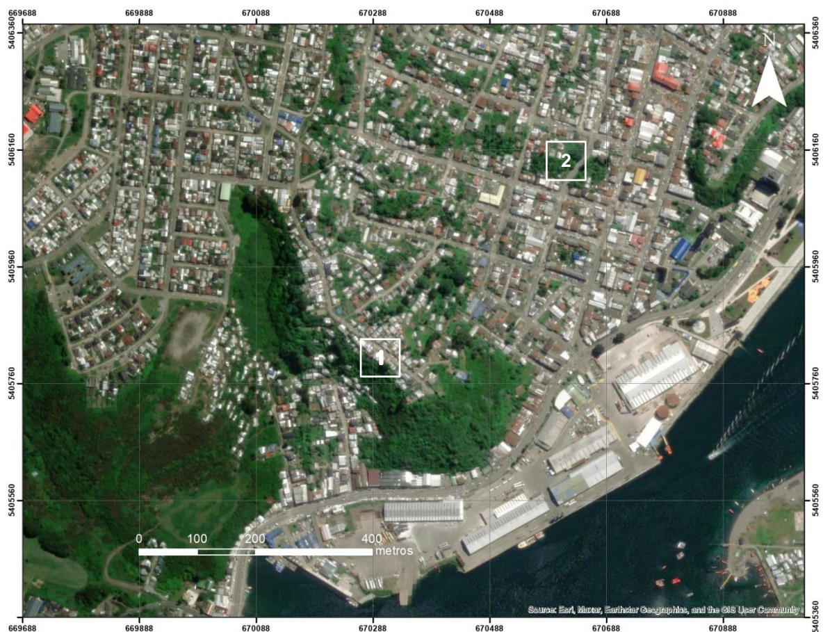
Figura 1. Imagen satelital del área portuaria de Puerto Montt, donde se destaca la ubicación de remociones en masa de ladera Angelmó (1) y calle Ecuador (2).
