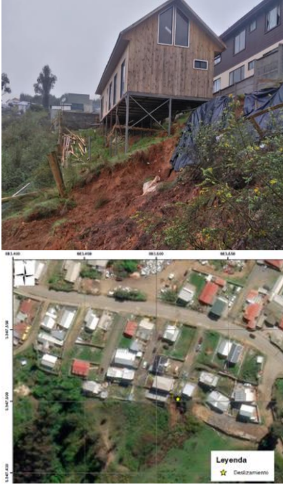
Fig.7. Remoción en masa en el sector de Lord Cochrane, catastrada en Minuta 1 (ver anexo) comuna de Tomé.
