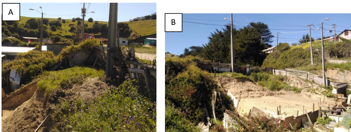
Figura 11.A. Vista hacia el norte de la casa afectada (casa 1 pasaje 3, caleta Chome). B. Vista hacia el este, frente al deslizamiento que afecta la calle 1. En el centro, se observa un poste de luz que se encuentra desestabilizado por efecto del deslizamiento.
