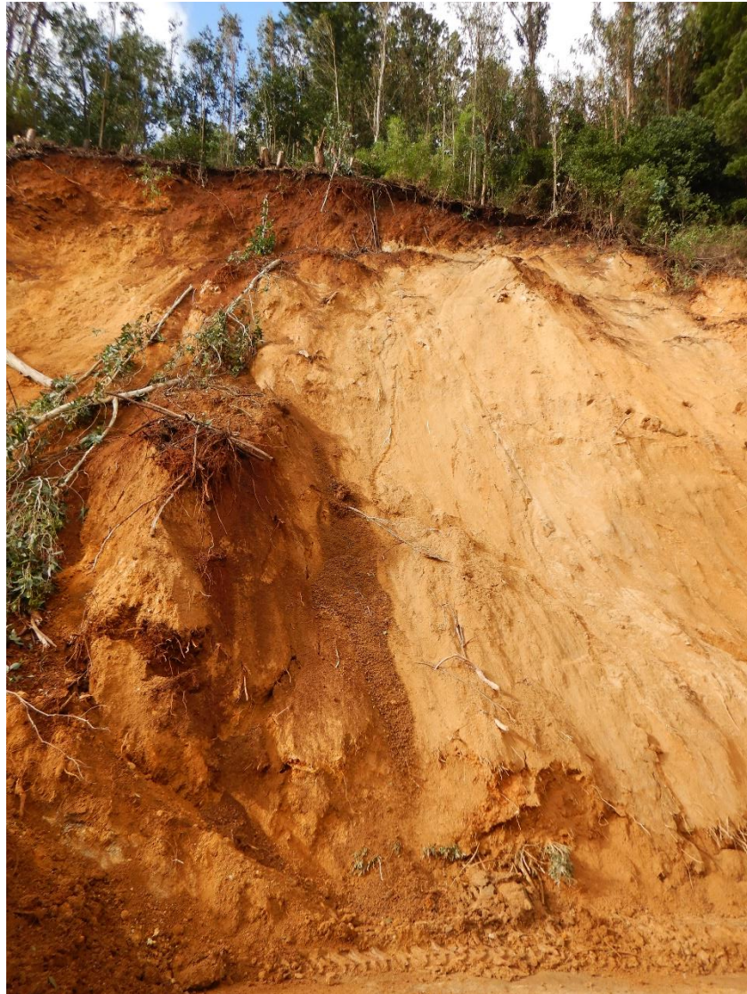
Fig. 3. Cicatriz del deslizamiento donde se puede apreciar la geología local, predominada por arcillas de color anaranjado.
