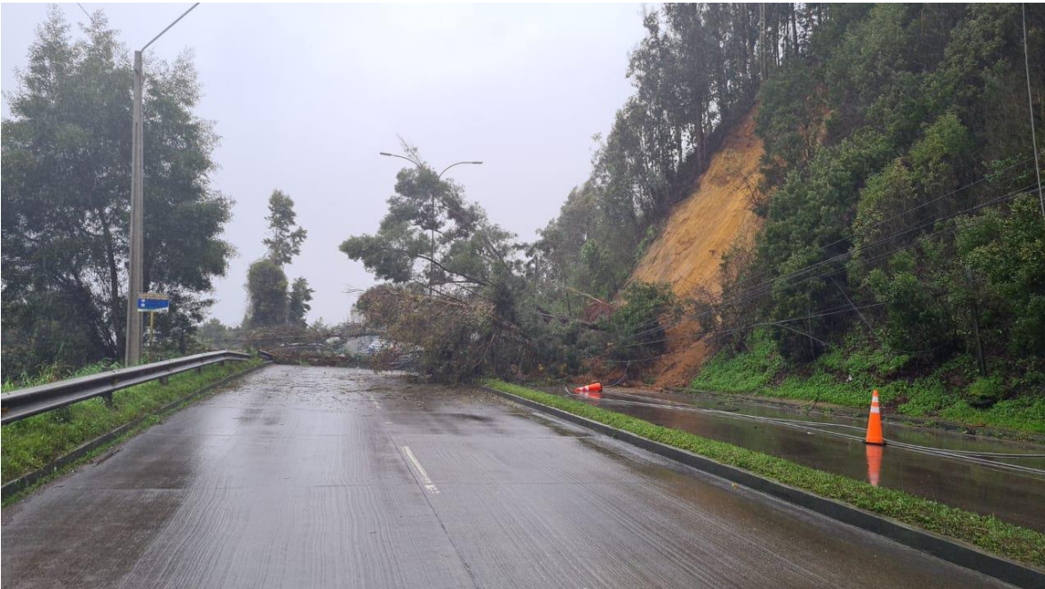
Fig. 8. Ruta O-60, sector Villuco, afectado por remoción en masa.
