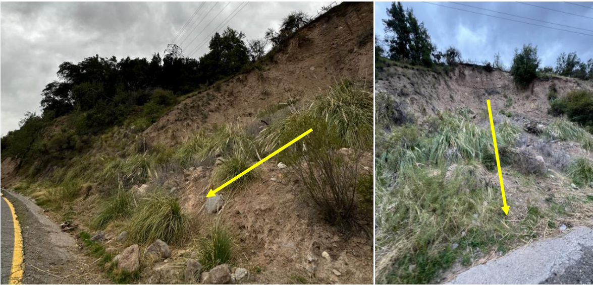
Figura 5. Deslizamiento de suelo en kilómetro 6, Ruta G-345 hacia Los Maitenes. Las flechas amarillas indican el sentido de desplazamiento del depósito.
