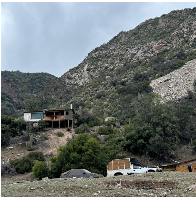
Figura 8. Casas ubicadas en la parte baja de ladera, altamente expuesta a caídas de roca.
