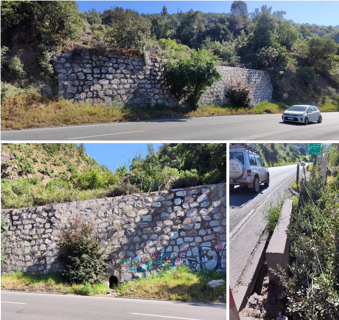
Figura 11. Arriba, vista del segundo muro de contención (sentido valle arriba). Abajo, izq., apertura aparentemente para drenaje de exceso de agua. Abajo der., obra de arte de salida de desagüe de escorrentía bajo la calzada, en costado opuesto del muro de contención.
