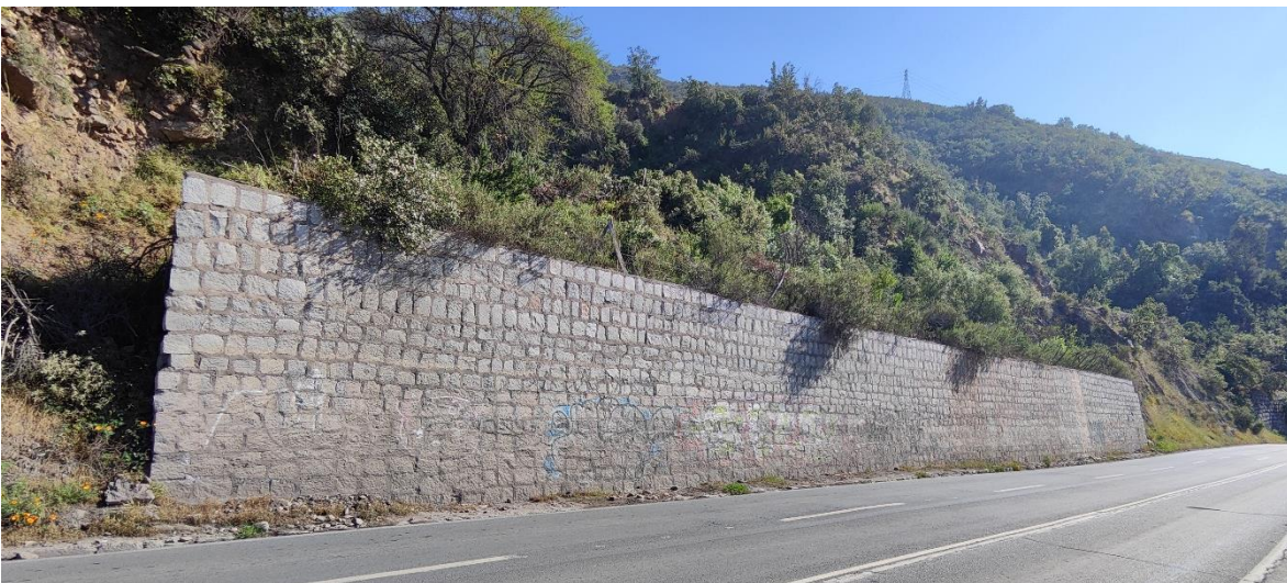
Figura 10. Vista del primer muro de contención (sentido valle arriba).
