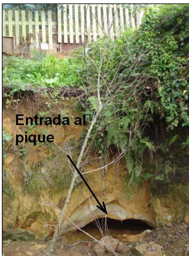
Figura 1. Entrada parcialmente obstruida a bocamina en el sector de Los Olivos, pasaje Nataniel.
