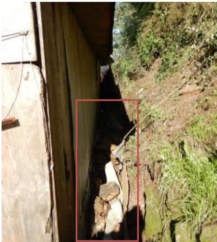
Fig. 7. Parte trasera de vivienda vecina ubicada a la izquierda del sitio estudiado. Se generó caída de rocas (rectángulo rojo) proveniente del lugar observado en Fig 6b, la noche previa a la visita del 18 de agosto, lo que sugiere que el proceso se encuentra activo y continuará deslizando material hacia esta vivienda en el futuro.
