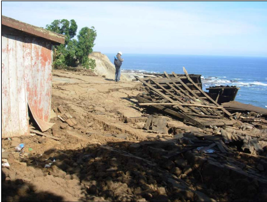
Fig. 3: Daños en viviendas de sector Caleta Hernández en borde de acantilado costero.
