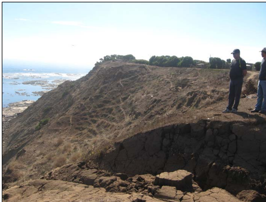
Fig 1: Grietas de tracción en el acantilado costero de Caleta Norte, con desplazamientos mayores a 1,7 m.
