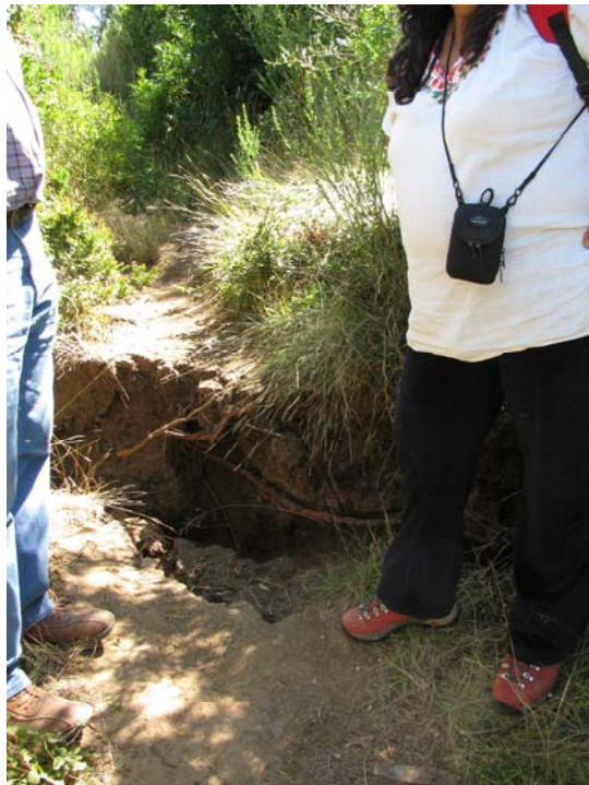
Fig. 4 Arauco, Población 12 de abril. Grieta con desplazamiento vertical de aproximadamente 40 cm.
