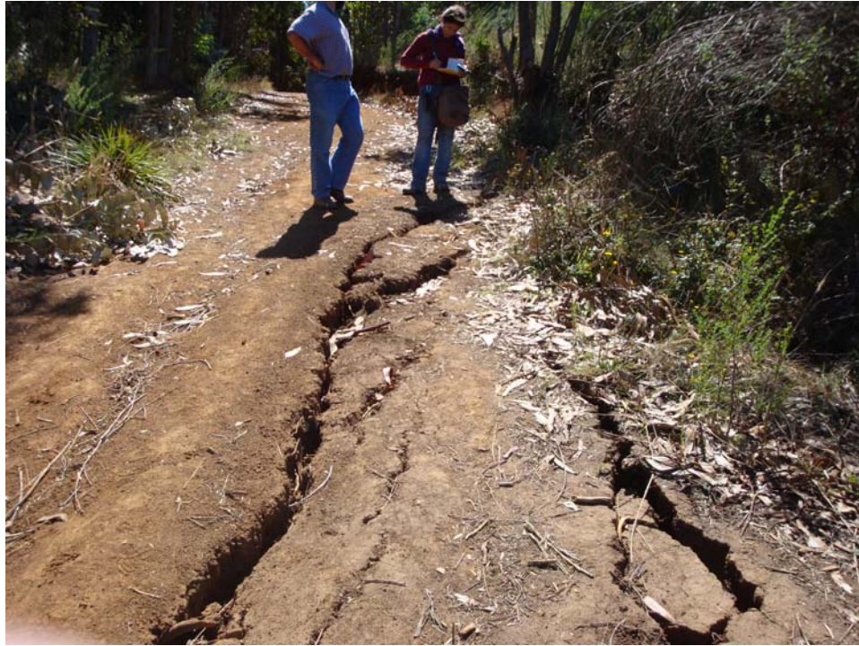
Fig. 3 Arauco, Población 12 de abril. Grietas de larga corrida formadas atrás del escarpe principal.
