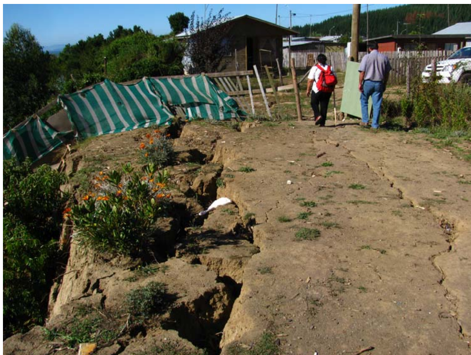
Fig.8: Arauco, Villa Alto Los Padres. Se observa la cabecera de un deslizamiento con su escarpe principal y grietas de tracción retrógrada que evidencia la formación de un nuevo escarpe y reactivación del deslizamiento. Se observa que estas nuevas grietas atraviesan las viviendas.
