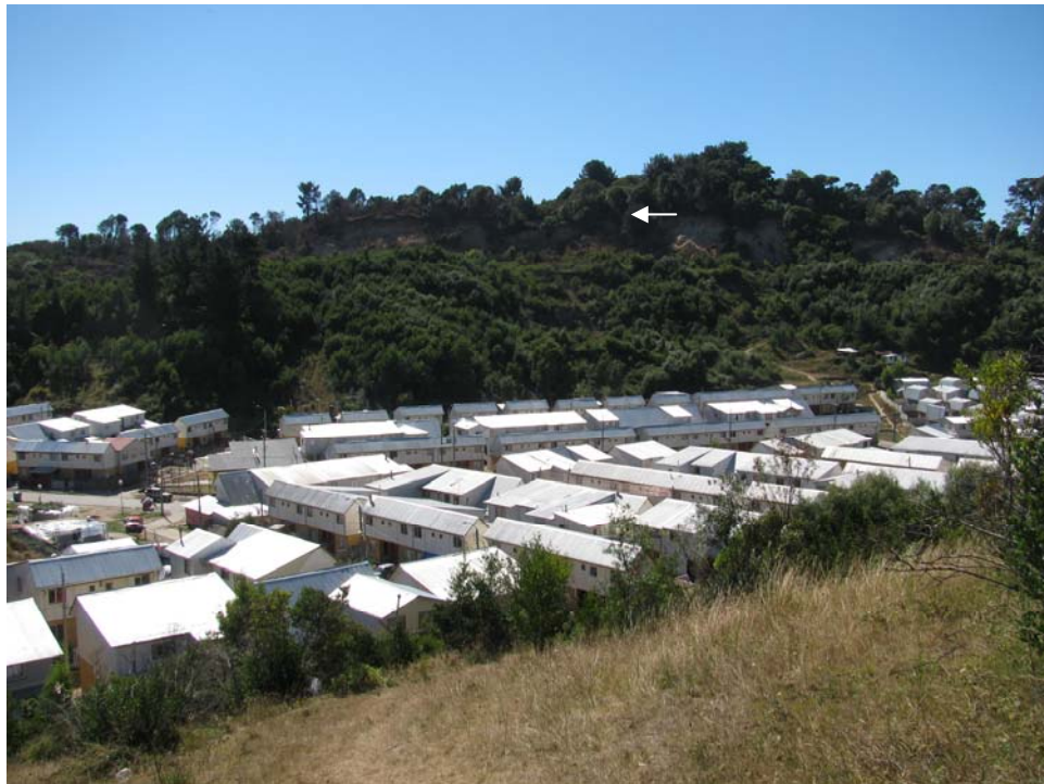
Fig. 6 Arauco, Villa Los Arrayanes. Deslizamiento activo frente a cerro de las antenas. Se observa que la población está fundada al pie del deslizamiento. Flecha blanca muestra el escarpe principal.
