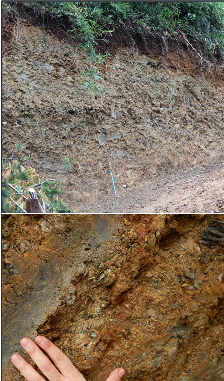
FIG. 6. Detalle del talud más alto observado.
