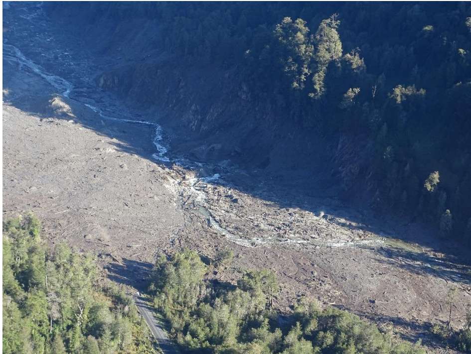
Figura 6. Vista del sector donde la masa deslizada impactó contra la pared opuesta del valle. Notar la erosión en la parte basal de la ladera hasta, al menos, 30 m.
