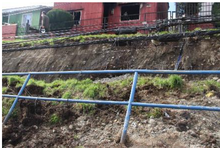
Figura 4. Fotografía del depósito donde ocurrió el evento. Se observa compuesto de arenas y gravas.
