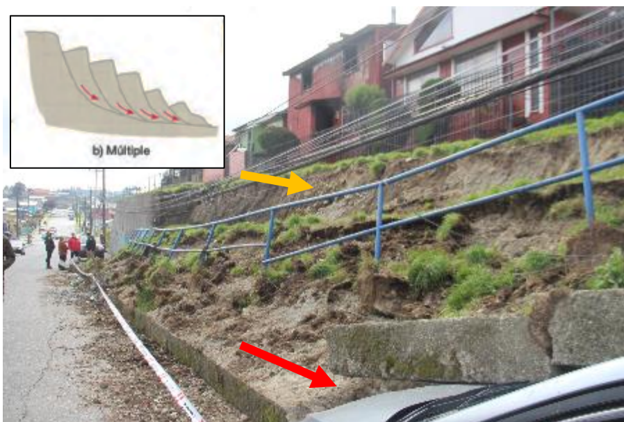
Figura 5. Fotografía del deslizamiento donde se observa el escarpe de deslizamiento (flecha amarilla) y el impacto al auto estacionado (flecha roja).
