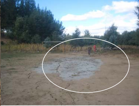
Fig. 2: Depósito de arenas finas arcillosas
