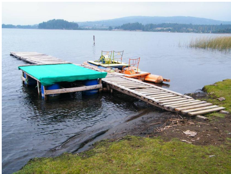
Fig. 3 Camping Chalhuaco, Lleulleu. Muelle donde se pudo medir un descenso del nivel del lago de 12 cm, utilizando los mismos trazadores orgánicos, es decir, marcas de algas en los pilares.
