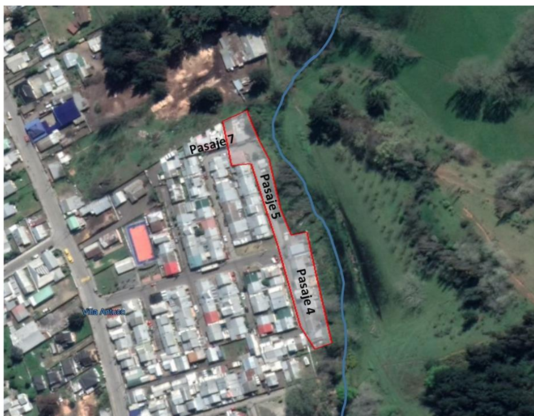
FIG. 5. Ubicación de las viviendas afectadas por hundimientos en el suelo de fundación y asentamientos diferenciales (delimitado en polígono rojo). Línea azul muestra trazado aproximado de curso de agua estacional que drena los sectores deprimidos circundantes.
