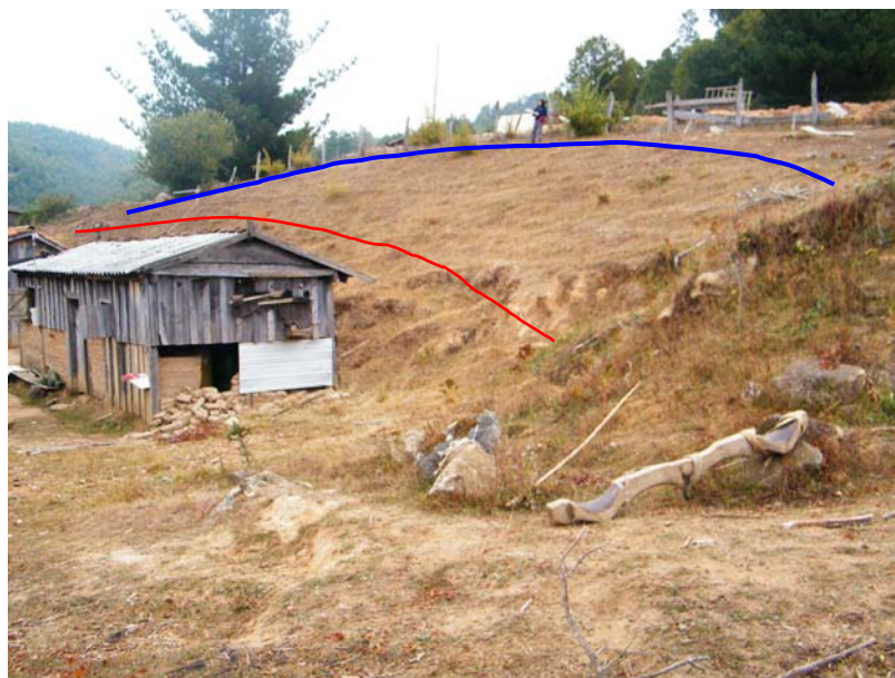
Fig. 3 Antigua corona de deslizamiento y ladera con una pendiente de 35° sobre las viviendas del Sr. Urra en Reñico. La planicie de la izquierda donde están las casas correspondía a una explanada del depósito de la remoción en masa. Se indica corona (azul) y grieta principal (rojo).
