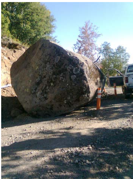
Figs. 1 y 2 Camino de acceso entre Los Sauces y San Ramón sector San Vicente. Izq. Bolón de granitoide que se desprendió desde el corte hacia el camino, el cual fue enterrado a un costado. Der. Bloque que se asentó durante el sismo y permanecía relativamente estable, con fracturas en su base de “maicillo” (flecha roja).
