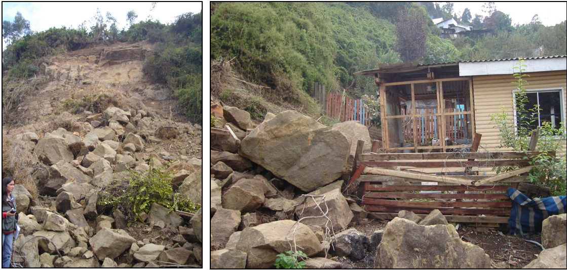
Figura 7: Izq. Muestra talud con pendiente muy fuerte, propenso a la caída de rocas por retroceso del acantilado costero inestable, con agrietamiento en la parte superior del talud principal. Der. Se observa vivienda destruida por bloques de roca de más de 2 m de diámetro que cayeron producto del movimiento sísmico del 27 de febrero.
