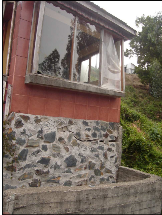
Figura 3: Colapso de viviendas y ampliaciones, por agrietamiento y asentamientos de los suelos de fundación, los mayores daños se observan en Pasajes Los Abetos y El Bosque.
