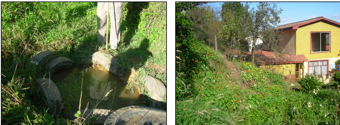
Figura 8: Muestra las vertientes y manantiales de agua que afloran en el sector de Población el Colo, que mantienen los suelos constantemente saturados en agua lo que favoreció los asentamientos durante el evento sísmico y puede gatillar fenómenos de remoción en masa. Se debe diseñar una adecuada canalización de las aguas subsuperficiales y aguas lluvias, para mitigar la saturación de los suelos.
