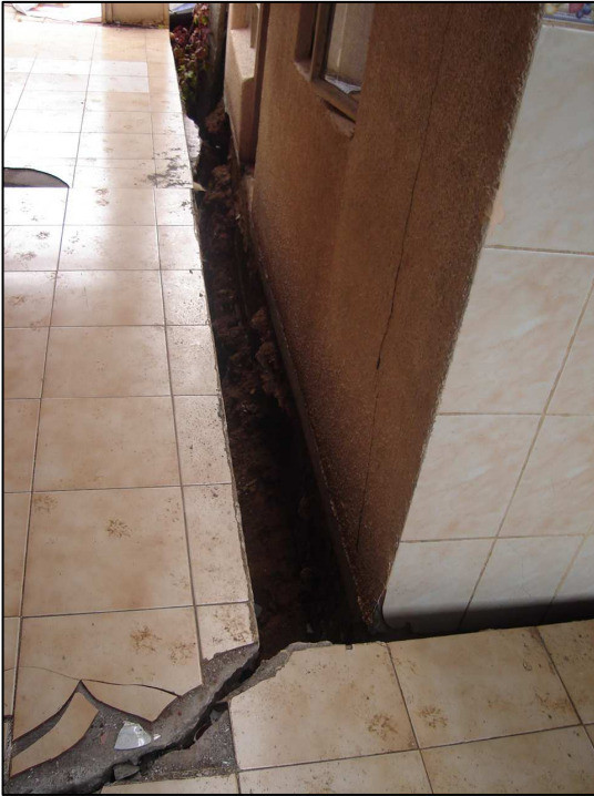
Figura 3: Colapso de viviendas y ampliaciones, por agrietamiento y asentamientos de los suelos de fundación, los mayores daños se observan en Pasajes Los Abetos y El Bosque.
