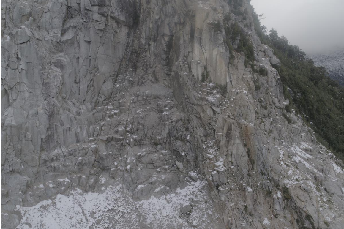
FIG. 7. Cabecera de la remoción con fuerte fracturamiento. Escarpe empinado y erosionado.
