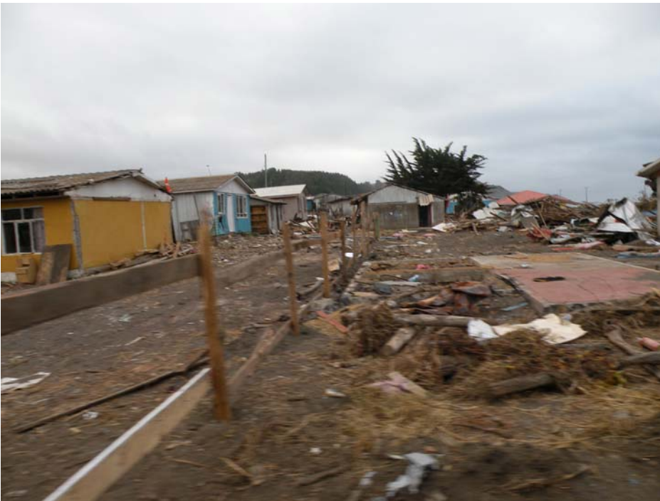
Figura 2: Vista al sur desde el centro del poblado de Perales.
