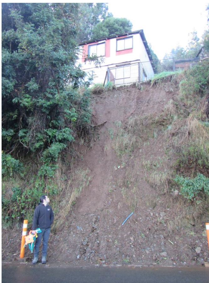
Figura 4.1. Vista de la vivienda construida sobre el talud de la ruta T-352. La casa se encuentra a un metro de distancia del borde superior del talud, se observa material depositado al pie del mismo, aunque la mayoría del material fue limpiado para restablecer el tránsito en la ruta.
